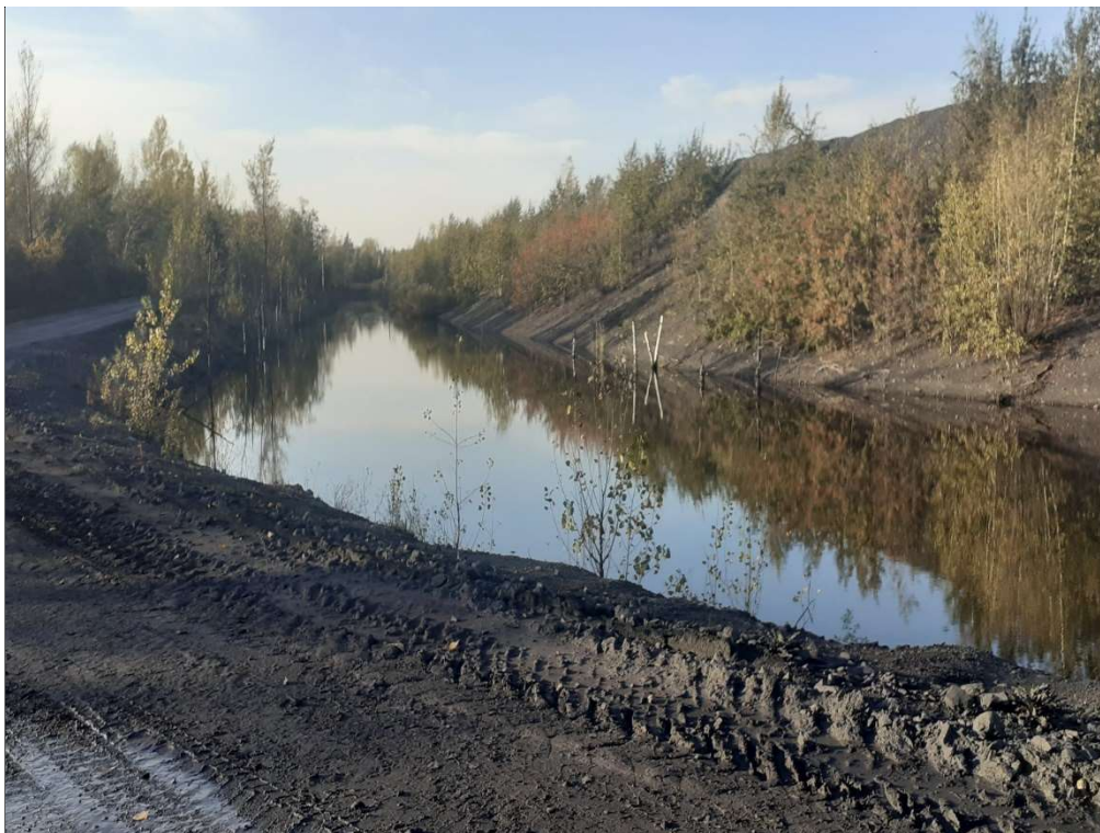
Snímek 21: poklesová oblast 4 – odkaliště ČSM-Polenčí , obvodový příkop kolem odkaliště „G“; vpravo násep odkaliště, vlevo účelová komunikace. Budoucí poklesy v nejnižším místě komunikace (EIA: 2,6 m; s dozníváním po 2018 až 3,2 m) způsobí její zatopení.
