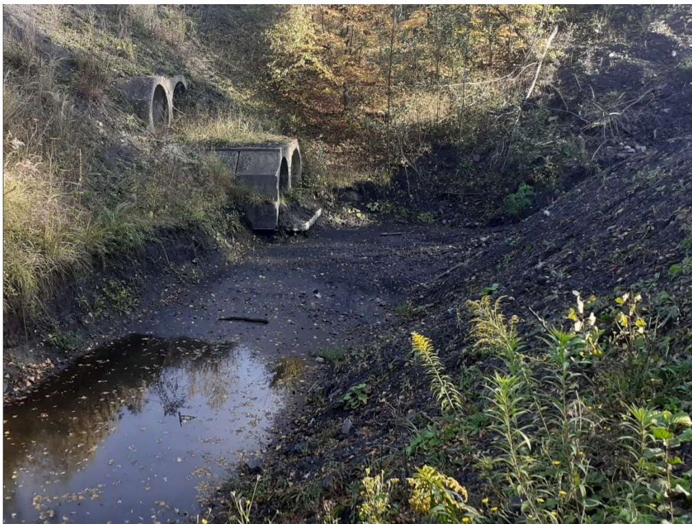
Snímek 7: poklesová oblast 2 – kolejiště ČSM-Sever , voda přitékající ze svahu je částečně zadržována na terénu vlivem špatných odtokových poměrů, způsobených poklesy terénu i antropogenními tvary (násypy hlušin). Částečně je převáděna do nižších částí terénu (severně od železniční trati) propustky.
