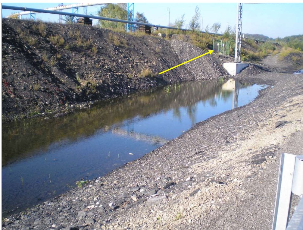
Snímek 37: Karviná-Doly: přechod karbonského okna do terasy Olše; rostlý terén je zakrytý mocnými vrstvami navážek hlušin; v oblasti je několik opuštěných důlních děl zajištěných odfukovými komínky (šipka).
