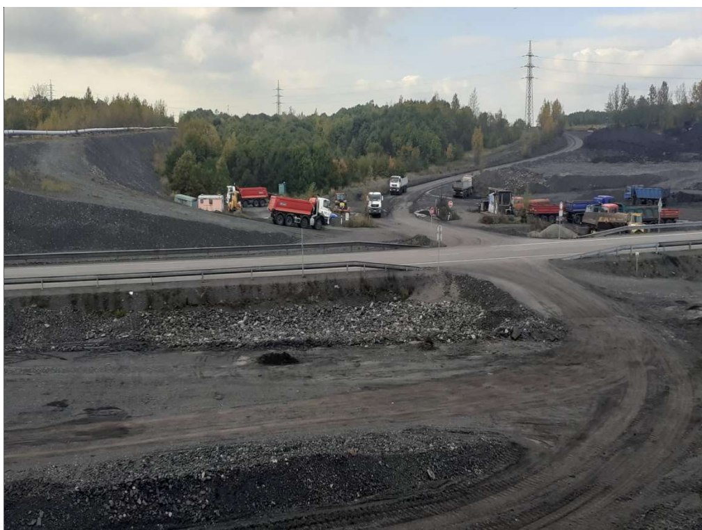
Snímek 10: poklesová oblast 3 – odkaliště ČSM - silnice , záběr z hráze mezi nádrží „G“ a „H“ na silnici II/475 v místě nejvyšších budoucích poklesů terénu. Vozidla na snímku zajišťují rekultivační práce západně od silnice.
