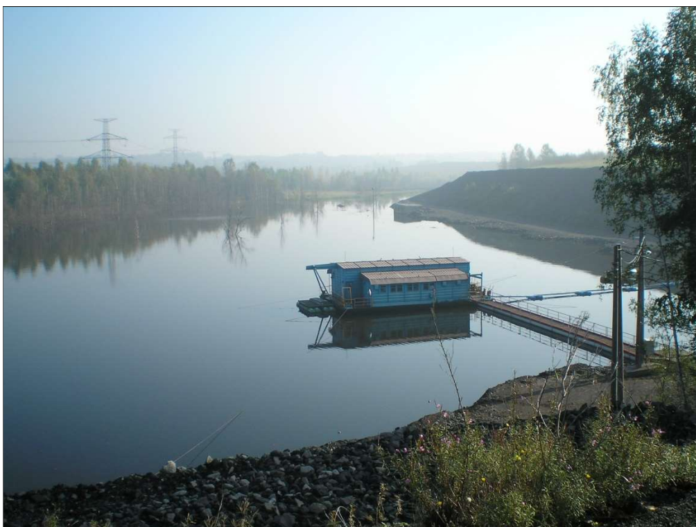
Snímek 42: nádrž E systému ČOV Dolu ČSM-Sever - dočišťovací koncová nádrž celého systému. Voda je využívána jako vratná v úpravně uhlí, přebytky jsou vypouštěny do Loucké Mlýnky, tekoucí podél SV okraje nádrže. Archivní snímek ; v současné době je plovoucí čerpací stanice nahrazena čerpací stanicí na břehu.
