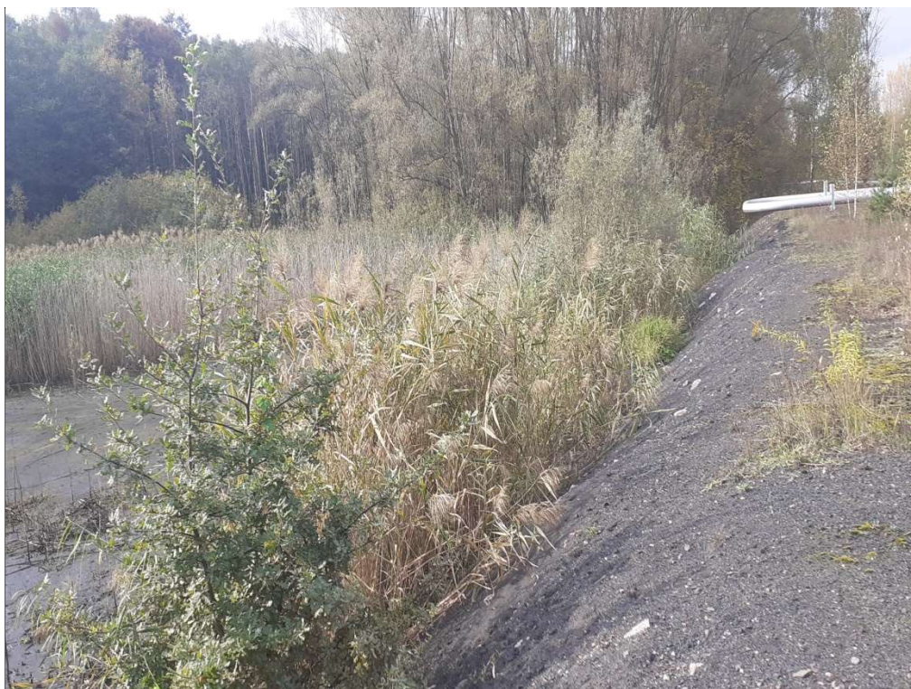
Snímek 13: poklesová oblast 3 – odkaliště ČSM - silnice , dtto; celkový pohled na násep plynovodu (potrubí vpravo nahoře) a hladinu zátopy (vlevo dole); převýšení je cca 2 m.
