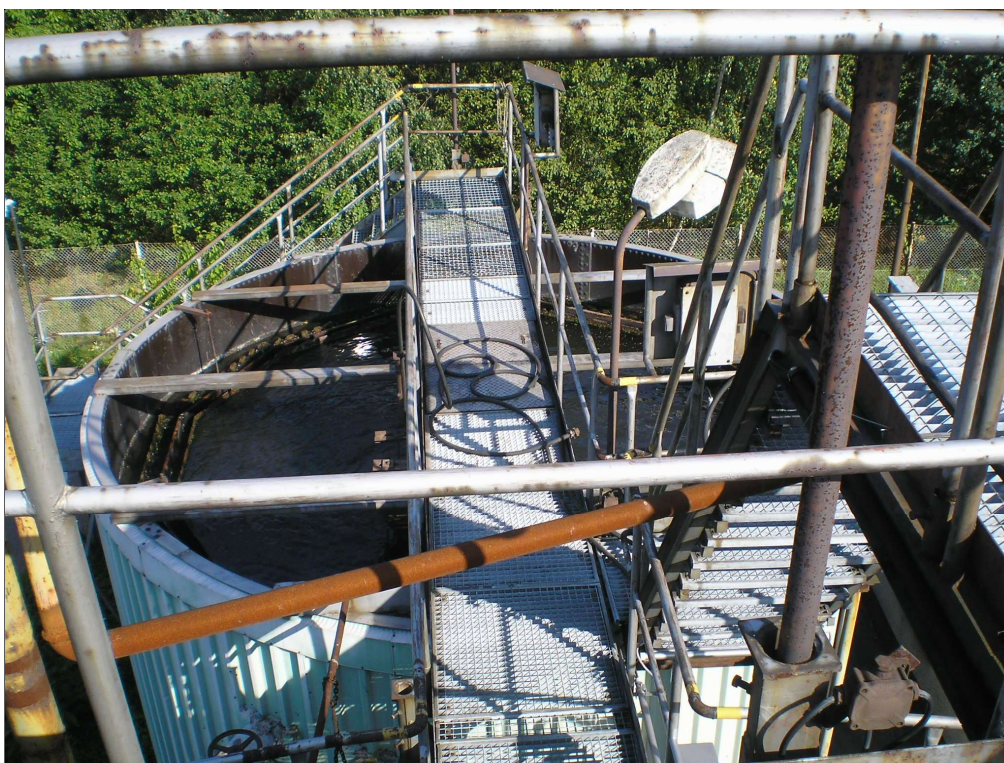
Snímek 40: ČOV splaškových vod Hydrovit 650S Dolu ČSM-Jih na okraji lesa; přečištěná voda je vypouštěná do bezejmenného potoka (ID CEVT 10208798), který je zaústěn do Loucké Mlýnky.
