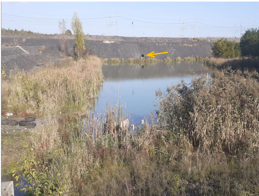
Snímek 31: poklesová oblast 6 – Paseky-pískovna , rozliv Velkého mlýnského rybníka pod tratí (násep v pozadí). Záběr od místní silnice směrem k východu. Vlivem protisměrných poklesů terénu voda z rybníka etážovými propustky (jeden z nich – šipka) podtéká trať a postupuje k západu, pod místní silnici (propustek v levém dolním rohu).
