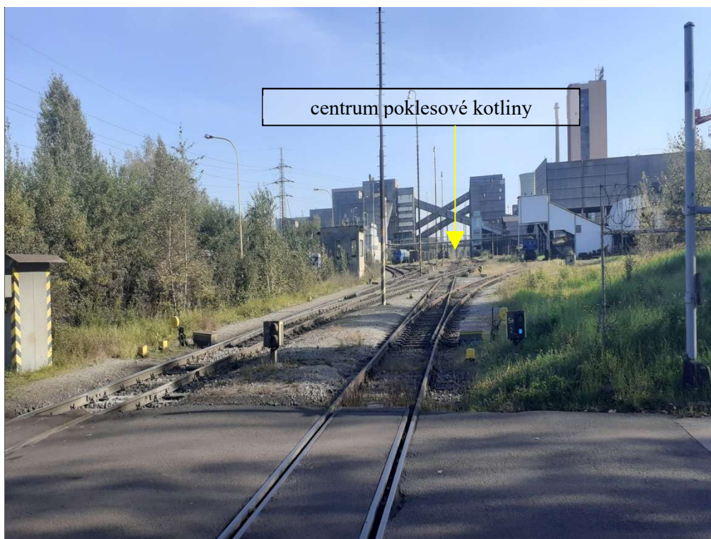
Snímek 4: poklesová oblast 2 – kolejiště ČSM-Sever , pohled na plochu za SV okrajem Dolu ČSM-Sever, kde se projeví vliv posledního plánovaného porubu č. 300 201/3, lokalizovaného pod kolejištěm vlečky PKP Cargo z ČSM na Darkov. Pokles terénu z tohoto porubu se předpokládá cca 50 cm; s doznívajícími vlivy cca 90 cm. V pozadí objekty úpravny dolu a skipová budova Dolu ČSM-Sever.
