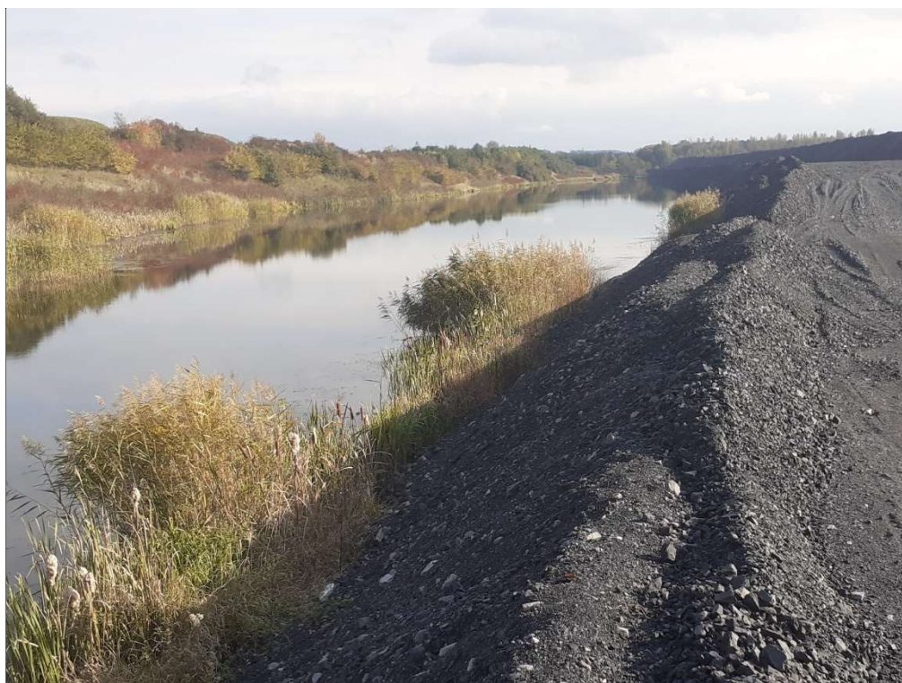
Snímek 16: poklesová oblast 3 – odkaliště ČSM - silnice , Loucká Mlýnka obtékající odkaliště „H“ (vpravo) od SV; vlevo je 8. rekultivační stavba území Louky. Dlouhodobé poklesy vytvořily stagnující úsek; pro udržení Mlýnky v korytě je nutno břehy zvyšovat. Vpravo za okrajem snímku je nádrž PDN.
