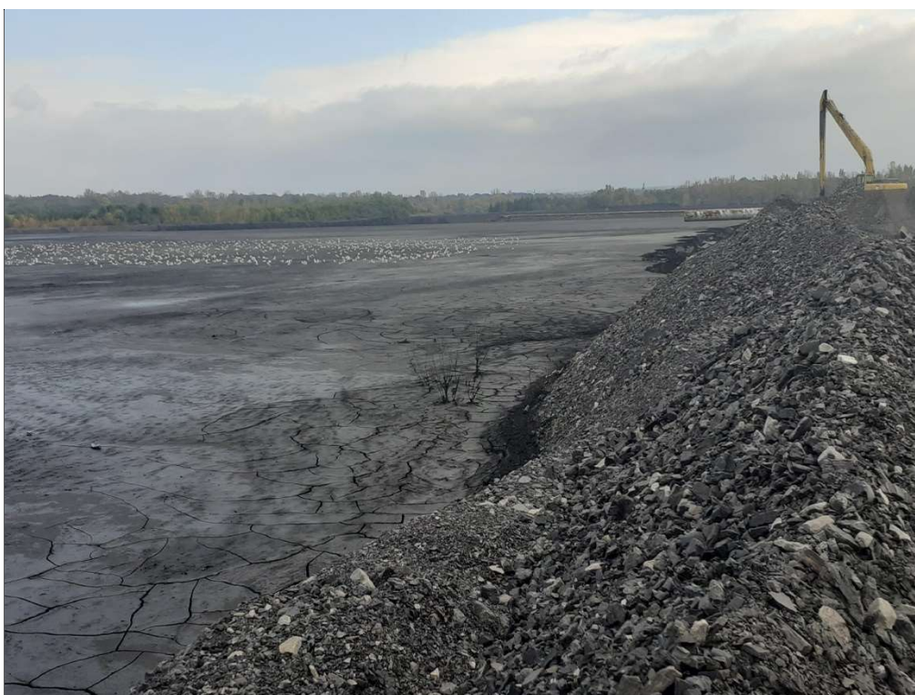
Snímek 8: poklesová oblast 3 – odkaliště ČSM - silnice , kalová nádrž „H“. Zde se předpokládá pokles až 4,5 m (EIA); se započtením doznívání přes 5 m. Maximum poklesové kotliny je v místě hráze mezi nádrží „H“ a sousední nádrží „G“.
