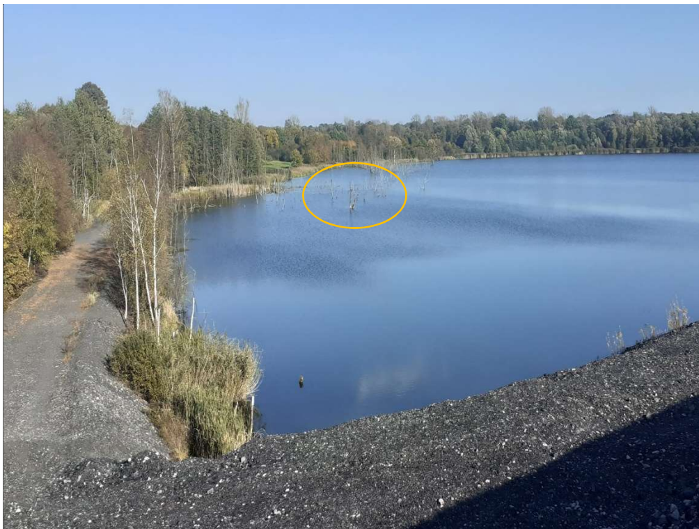
Snímek 35: východní okraj poklesové oblasti 6 – Paseky-pískovna , Velký Mlýnský rybník, záběr z tělesa železničního koridoru Dětmárovice – státní hranice se SR směrem k východu. Utopené stromy (elipsa) dokládají změny rozsahu vodní hladiny vlivem poklesů terénu.
