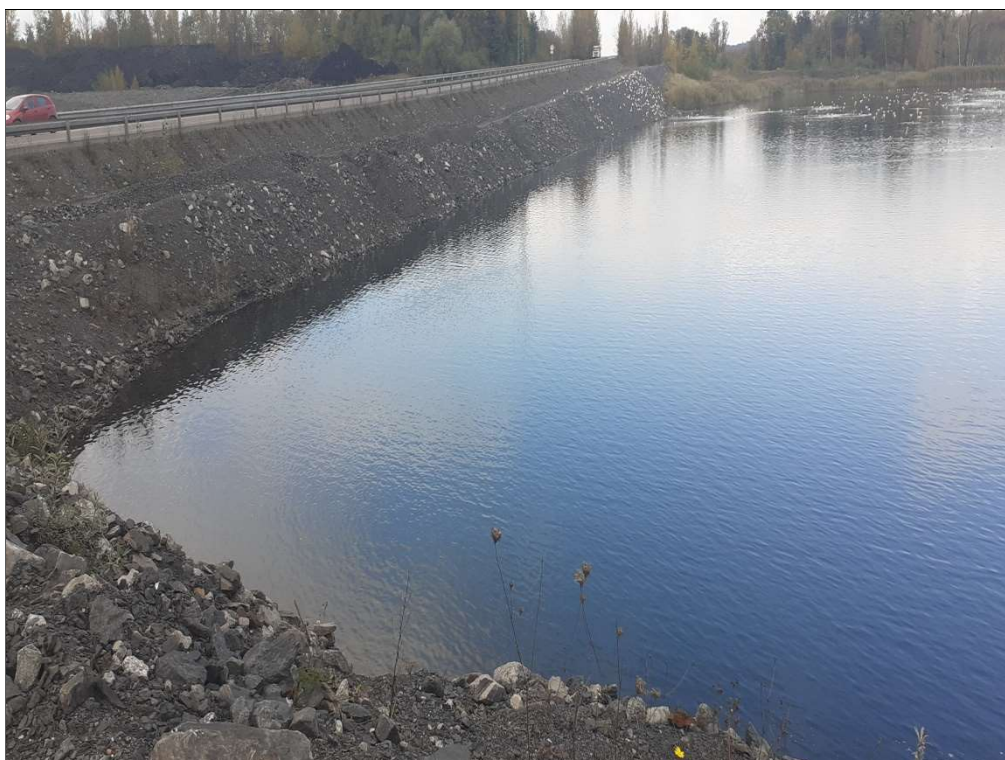
Snímek 44: pomocná dočišťovací nádrž (PDN) pod odkalištěm „H“ Dolu ČSM-Sever, soustřeďující vodu z nádrže G a H k jejímu dočištění. Voda následně odtéká do koncové nádrže E (viz snímek 42).
